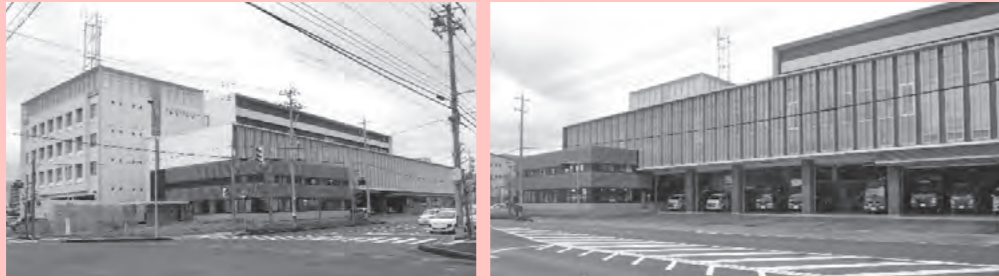
消防本部・敦賀消防署庁舎
