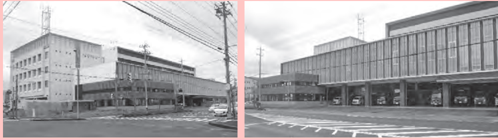
消防本部・敦賀消防署庁舎
