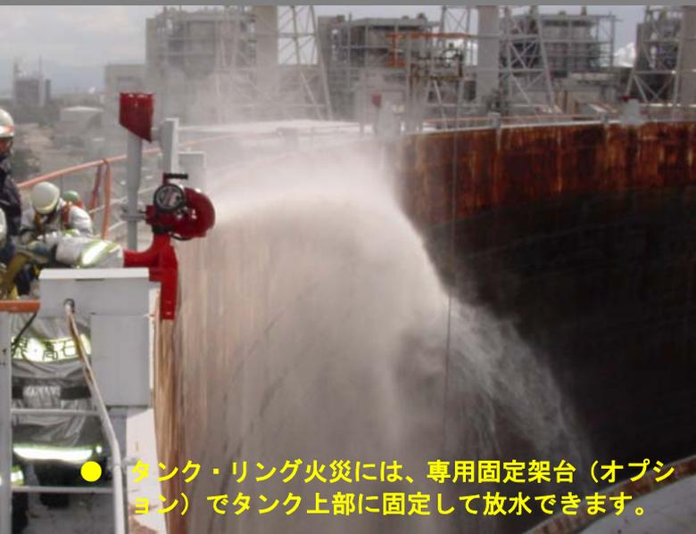
●タンク・リング火災には、専用固定架台（オプシ
